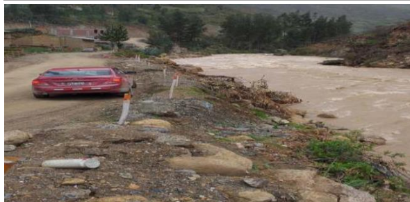
Flujo de agua por alcanzar la plataforma de rodadura de la carretera Yanahuanca - Ambo
